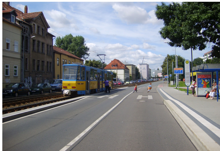
Abbildung 3: Haltestelle Gartenstraße / Lutherstraße nach Umbau
