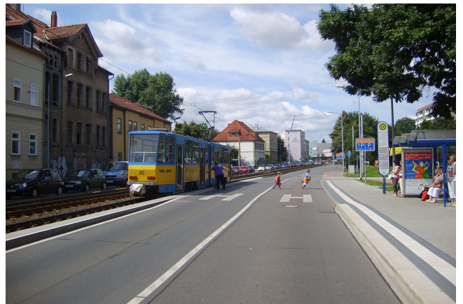
Haltestelle Garten- / Lutherstraße nach dem Umbau
