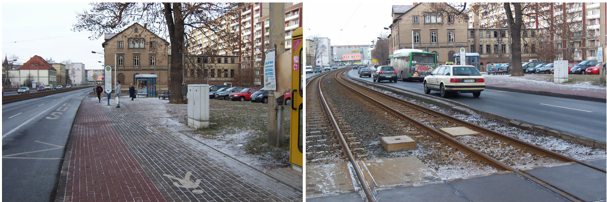
Abbildung 1: Haltestelle Gartenstraße / Lutherstraße vor dem Umbau
