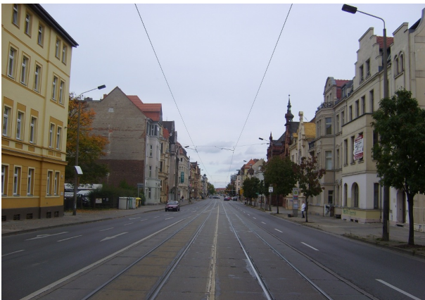
Abbildung 3: Bahnhofstraße vor der Umgestaltung
