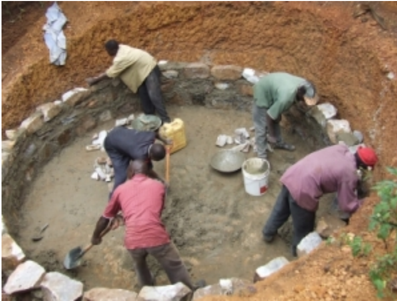
Foto: Seit Beginn des Projektes wurden tansanische Arbeiter im Zisternenbau fortgebildet, dadurch stehen mittlerweile mehrere Bauteams zur Verfügung, die an der Wasserversorgung der Region arbeiten
