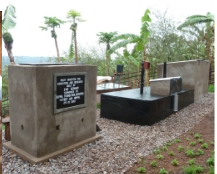
Foto: Fertige Pilot- und Forschungsanlage zur Erzeugung von Biogas aus pflanzlichen Abfällen
