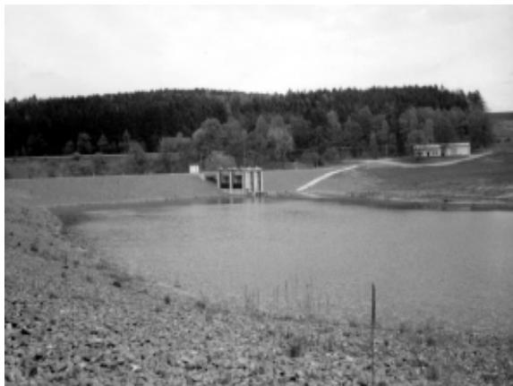
Damm mit Auslassbauwerk und Dauerstau, Foto: Talsperrenmeisterei Schönbrunn
