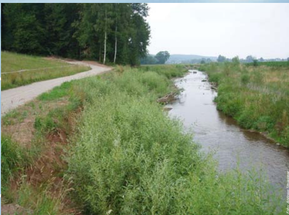
Ingenieurbioologische Ufersicherung
