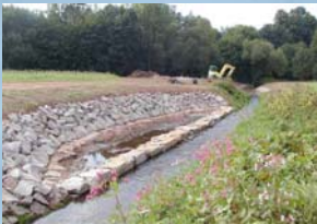
Konventionelle Bauweise mit Steinsatz
