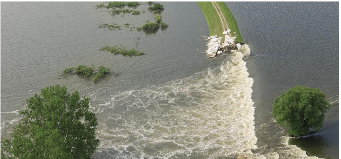
Technischer Hochwasserschutz bietet keine absolute Sicherheit vor der Flut. Foto: Steffen Bohl
