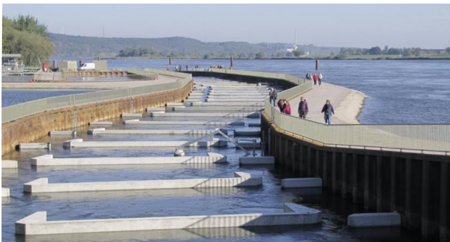
Das Elbewehr in Geesthacht ist weiterhin das größte Wanderhindernis in der Elbe. Der 2010 fertiggestellte Fischpass am Nordufer gibt jedoch Hoffnung. Er ist 550 Meter lang, die 49 Becken sind jeweils 16 Meter breit, 9 Meter lang und rund 1,75 Meter tief. Die Schlitzlöcher sind 1,20 Meter breit. Foto: René Schwartz
