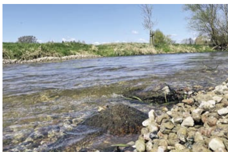
Links: Unter Anleitung des verantwortlichen Gewässerwarts wird Laichkies gezielt in den Fluss unterhalb des Dossower Wehres eingebracht. – Mitte: Blick auf die neu geschaffenen Laichkiesbänke in der Gewässersohle – Rechts: Blick von der verbliebenen Brücke des ehemaligen Wehres in Richtung der neuen Laichbetten.
