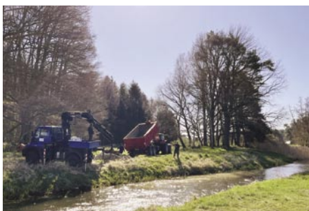
Links: Unter Anleitung des verantwortlichen Gewässerwarts wird Laichkies gezielt in den Fluss unterhalb des Dossower Wehres eingebracht. – Mitte: Blick auf die neu geschaffenen Laichkiesbänke in der Gewässersohle – Rechts: Blick von der verbliebenen Brücke des ehemaligen Wehres in Richtung der neuen Laichbetten.
