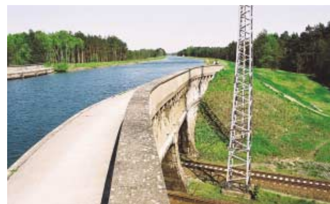
Künstlicher Gewässerabschnitt: Blick auf die Trogbücke über die Bahnlinie am Oder-Havel Kanal bei Eberswalde
