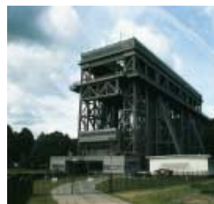
Kandidat für künstliches Gewässer: das Schiffshebewerk Eberswalde-Finow am Oder-Havel Kanal
