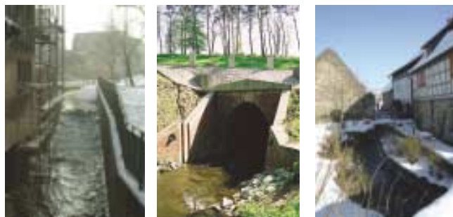
Kandidaten für erheblich veränderte Gewässerabschnitte: Umflutkanal der Werra in Meiningen; Düker unter dem Oder-Havel-Kanal; Werraabschnitt mit altem Mühlrad in Troststadt (von links nach rechts)
