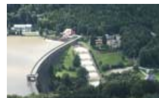
Talsperren zählen zu den erheblich veränderten Gewässern. Foto: M. Zebisch
