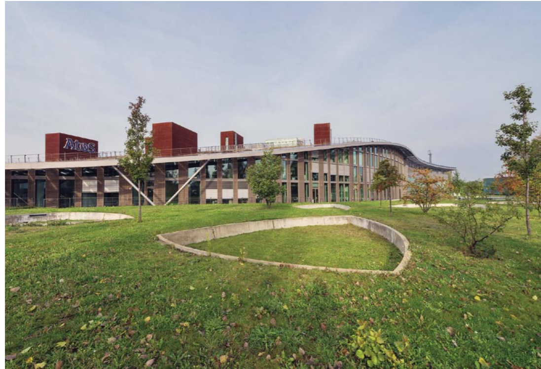
Das ehemalige Solon-Gelände in Adlershof. Dachbegrünung, Teiche und Rigolen halten das Regenwasser komplett auf dem Grundstück zurück.
