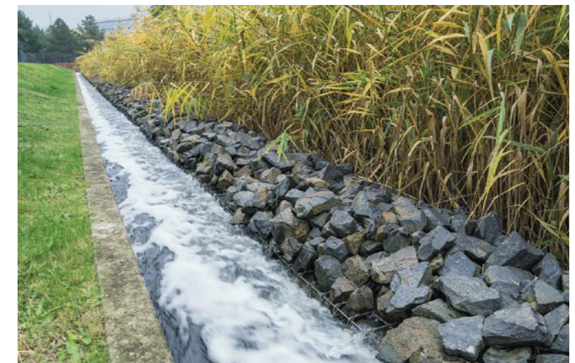
Der Retentionsbodenfilter mit Regenklärbecken in Adlershof entlastet den Teltowkanal, indem er das gereinigte Regenwasser zeitverzögert in das Gewässer einleitet.
