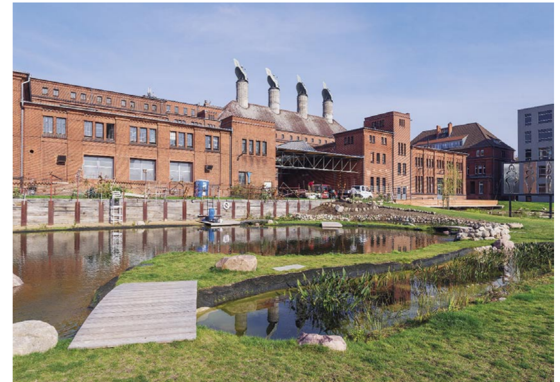
Durch Dachbegrünung und künstliche Wasserflächen auf dem Gelände der IGG Malz-fabrik in Schöneberg erfolgt nicht nur die Retention von Regenwasser – das Wasser kann auch als Betriebswasser verwendet werden.
