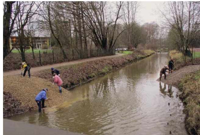
Bachab der Rosengartenbrücke, Pinneberg, wurden 2017 erste Kies-Depots in die Böschung der Mühlenau geschüttet und 2019 als Lenkbuhnen in das Flussbett integriert.
