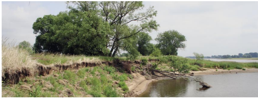
Lateralerosion unterhalb eines nicht geschlossenen Buhnewurzeldurchrisses am linken Elbufer am Kilometer 354,4 Foto: Karl-Heinz Jährling
