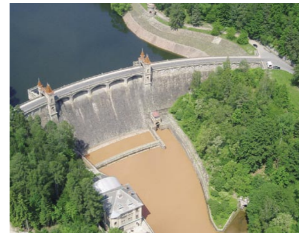
Talsperre Les Království an der tschechischen oberen Elbe am 24. Mai 2007. Über den Grundablass abgeleitete, vom Sediment gefärbte Hochwasserwelle.
