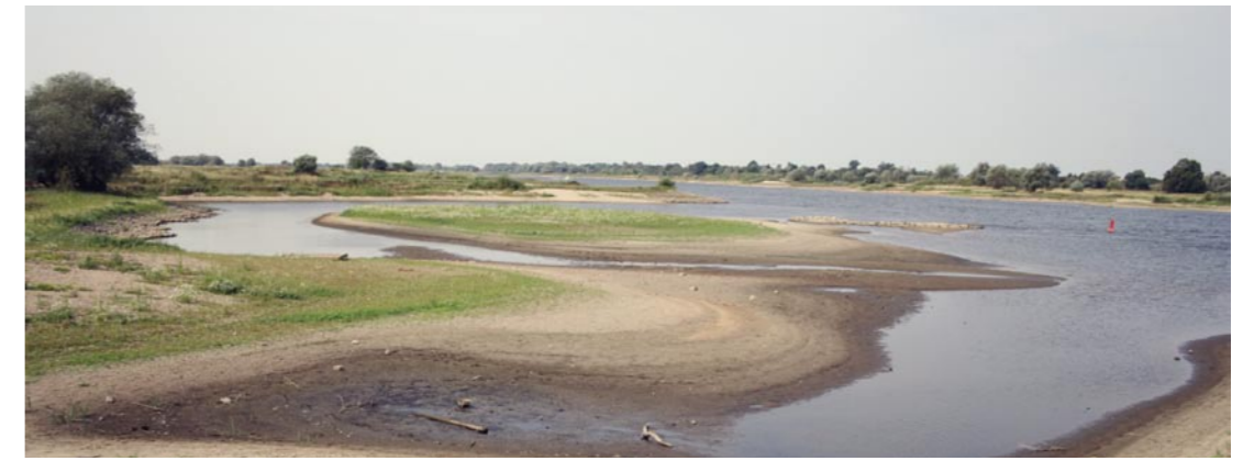
Akkumulation feinmineralisch-organischer Sedimente in Buhnenfeldern im Niedrigwasseraspect am rechten Elbufer am Kilometer 361. Foto: Karl-Heinz Jährling
