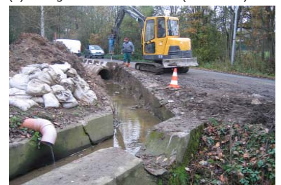
(3) Entfernen der Beton-Ufersicherung
